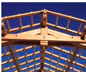
Toit plat, charpente traditionnelle ou fermettes, de nombreuses solutions s'offrent à vous. Pour fabriquer les pièces de la structure, nous utilisons les techniques de taille manuelle et traditionnelle associées des machines à commandes numériques.
